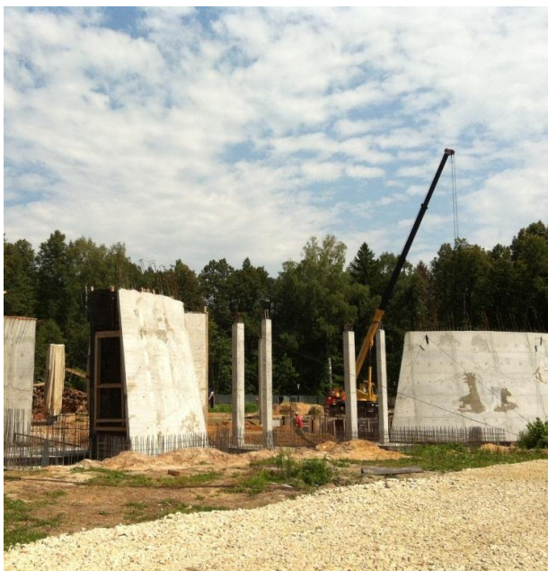
Начальный этап строительства планетария (июль 2012 года).
